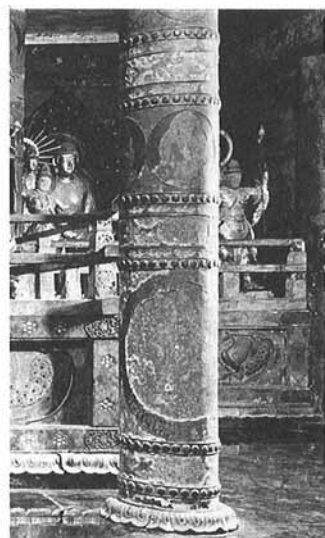
3 螺鈿大円文 (良柱、修理前)
