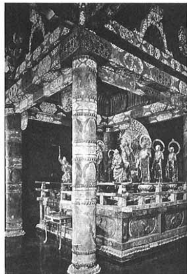
1 金色堂内陣修理前
