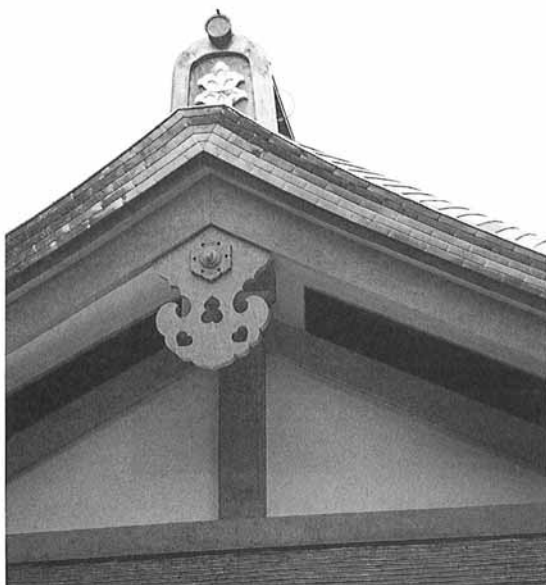
平成十一年十月 屋根正面より
