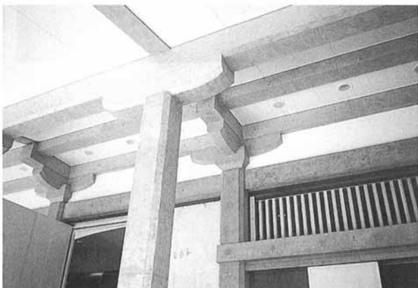
平成十一年十月 既製コンクリート工事 肘木・斗組み
