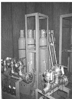
平成十一年十月 消火設備 ハロン消火ポンベセット施工中
