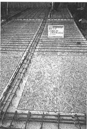
平成十年七月 土工事土間木織板敷込
