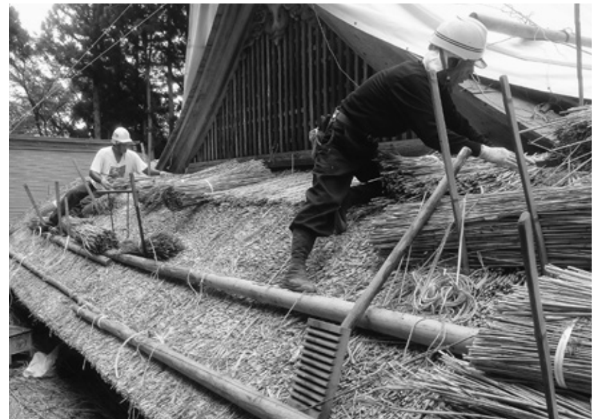
屋根葺き替え工事の様子（請負業者：有限会社熊谷産業）
