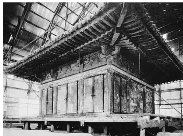
修理前の金色堂（東北面より）
