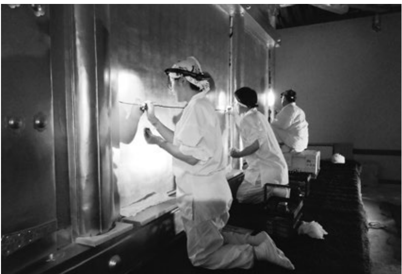
金色堂の修復作業（令和2年度）
